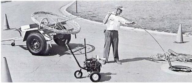
las Varillas deben ser rotadas, para lo cual deben ser desconectadas del Carrete. El extremo de la varilla debe ser conectado a través del Eje Rotatorio de la maquina Rotadora de Varillas y ser asegurado. Ahora las varillas pueden ser rotadas mientras el
