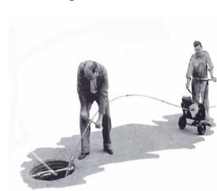
El Operador de la Maquina Rotadora esta controlando la velocidad de rotación. Si el avanzar se dificulta, los dos Operadores trabajando juntos pueden mover las varillas hacia atrás y volver a empujar, y así las varillas tomarían rotación inversa de manera rápida hasta que pasan a través de la obstrucción.
